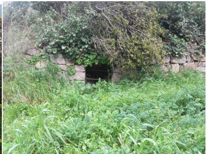
Muro a secco da ripristinare
